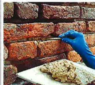
Architetture Intervento su un paramento murario con malte eseguite ad hoc con materiali naturali
